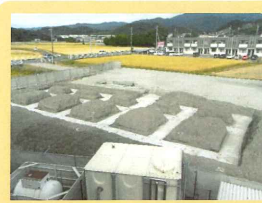
捨コン打設完了
